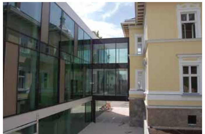
Der Übergang von der renovierten Villa in den Neubau
