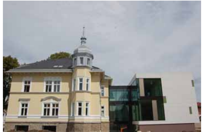
Alt- und Neubau harmonieren perfekt miteinander.
