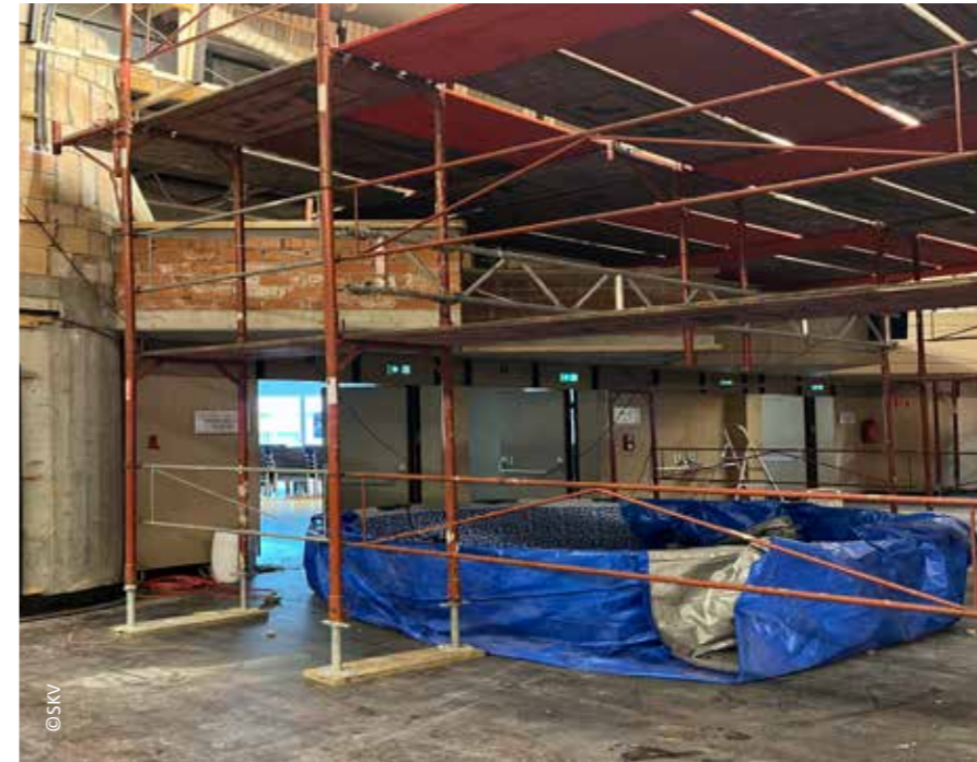
Blick hinter die Kulissen: Das provisorische Auffangbecken und das freigelegte Ziegelmauerwerk zeigen die Dimensionen des Wasserschadens im Stadtsaal.
