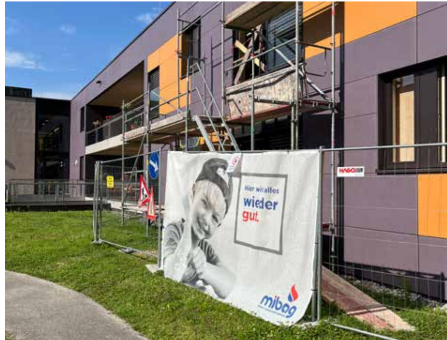
Der beschädigte Gebäudeteil des Seniorenheims wurde eingerüstet. Das beim Zimmerbrand betroffene Zimmer wurde saniert und kann in Kürze wieder bewohnt werden.
