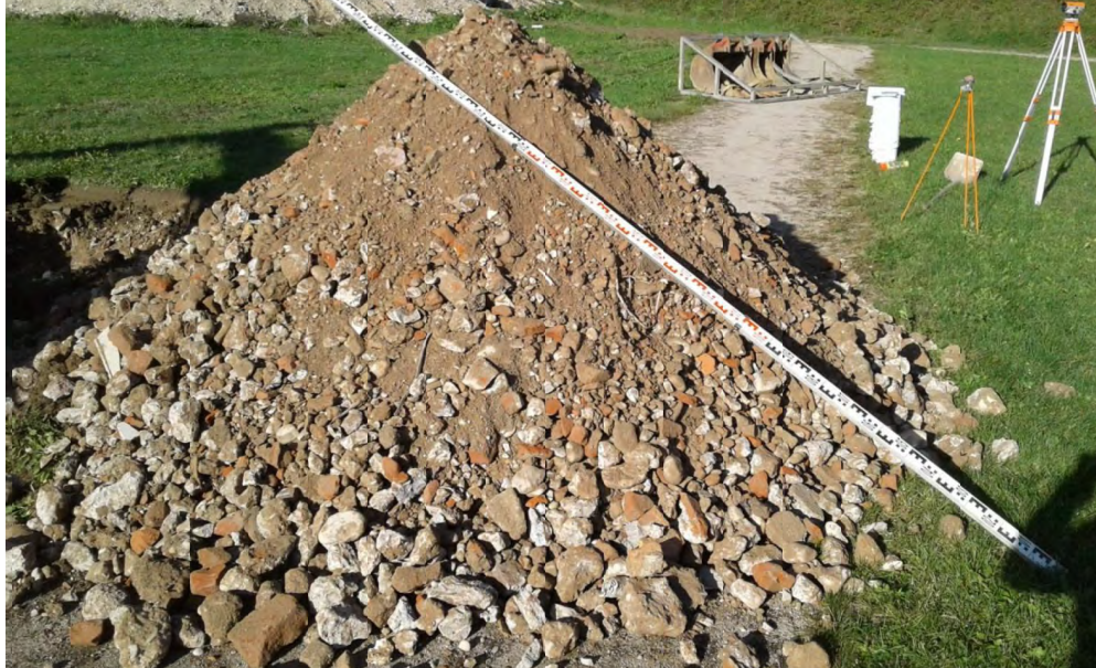
Aushub Schürfgrube beim künftigen Schulcampus
