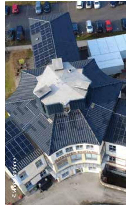
Kostengünstiger Strom durch die eigene PV-Anlage auf dem Dach
