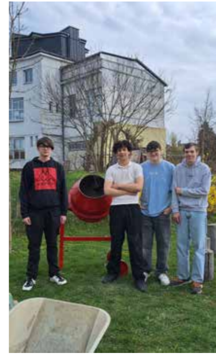
Schüler:innen der Polytechnischen Schule bereiten mit großem Einsatz das Fundament vor.
