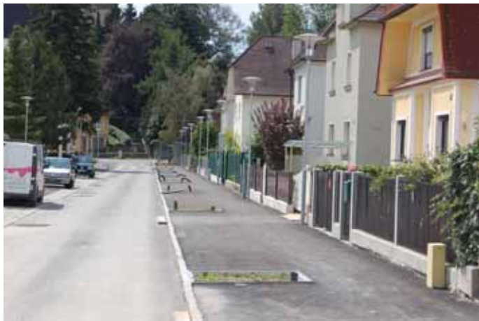
Ein Teil der Schererstraße wurde bereits frisch asphaltiert.
