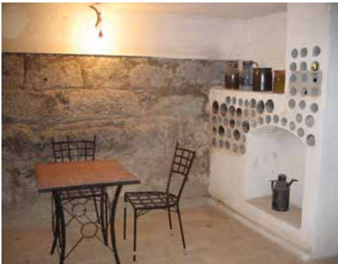
Relikte der Vöcklabrucker Stadtmauer
