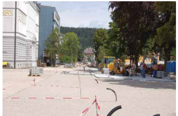
Am Schulvorplatz der Volks- und Hauptschule sowie im nördlichen Bereich der Schererstraße wird zur Zeit noch fleißig gearbeitet.
